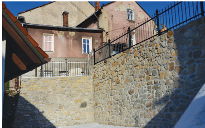
Obecny mur obronny po remoncie – 10 stycznia 2017 r.
